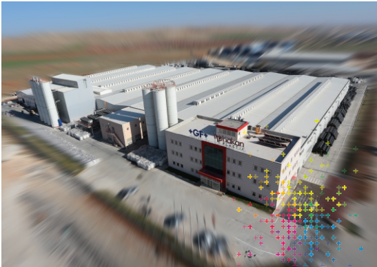
Georg Fischer Hakan Plastik Şanlıurfa Üretim Tesisleri
